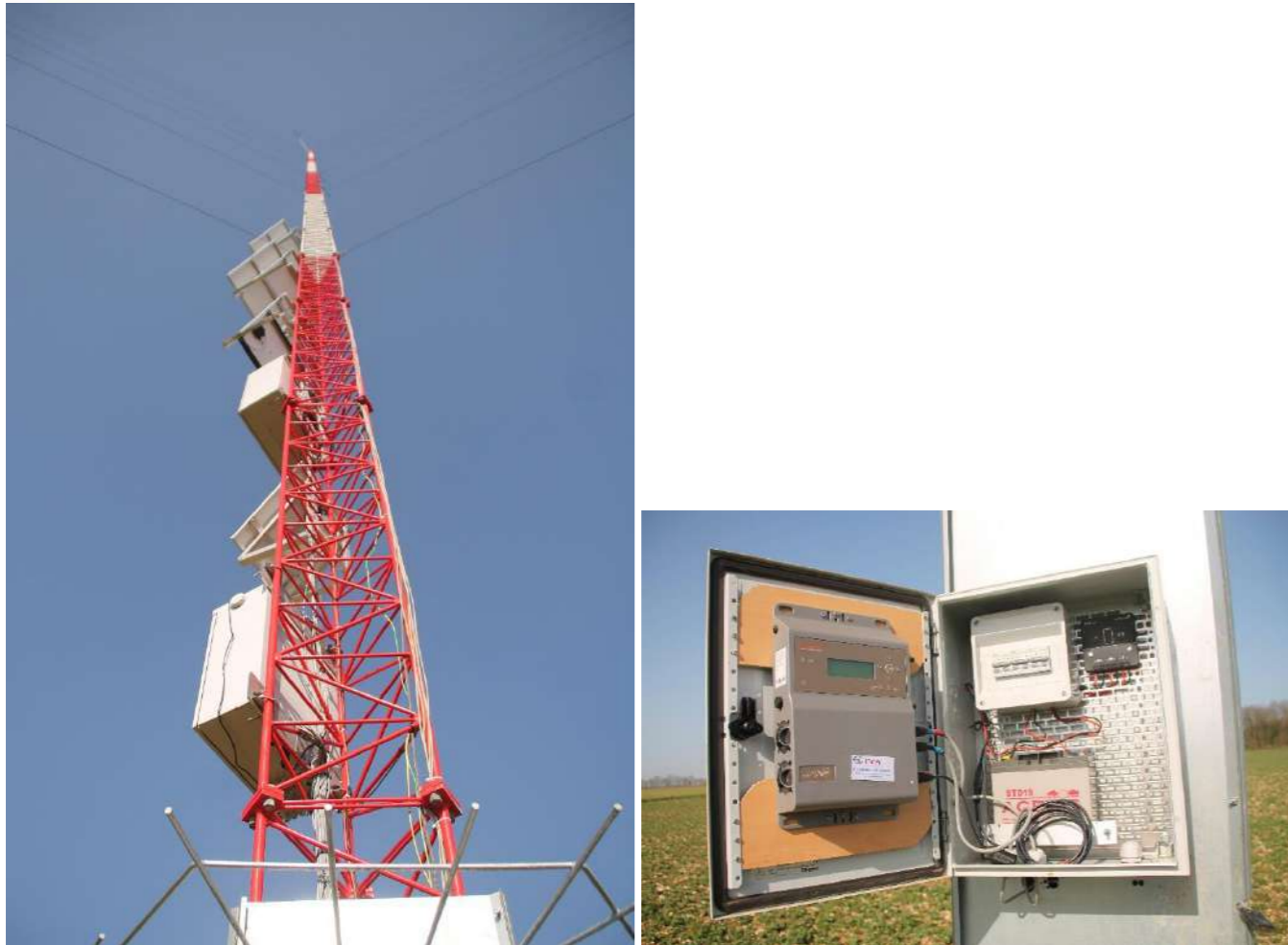
Figure 54 : Installation du mât de mesure et du matériel d'enregistrement (SM3BAT) ©NCA Environnement
