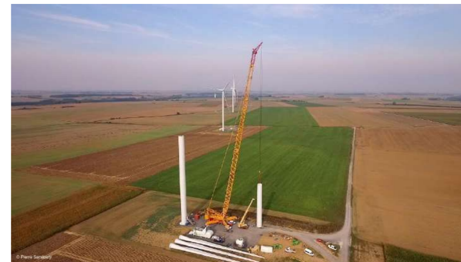
Figure 3 : Vue aérienne d'une plateforme de montage Source : JPEE
